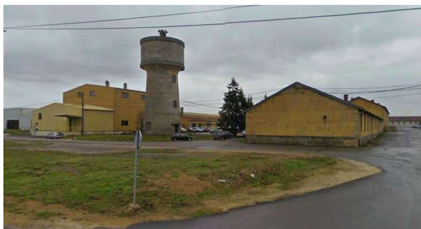
Site VITHERM FRANCE SA à Etain
