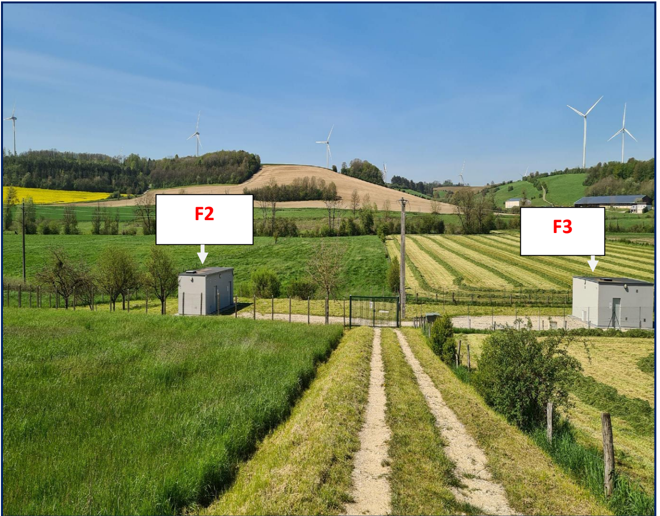
Vue d'ensemble sur le PPI des deux forages de 55-COURCELLES-SUR-AIRE exploités par le SMGG (photo : CV)
